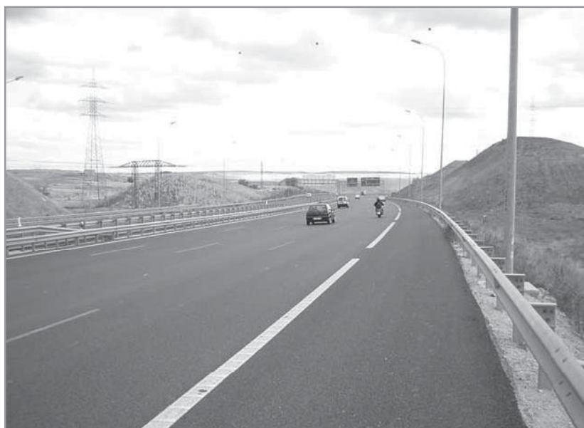
Foto 1. Los sistemas de contención de vehículos, situados en márgenes y medianas, retienen a los vehículos que abandonan la calzada y los redirigen a su trayectoria original.
