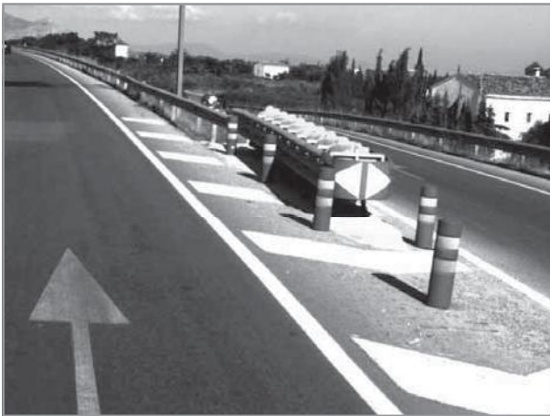
Foto 8. Amortiguador de impacto.
