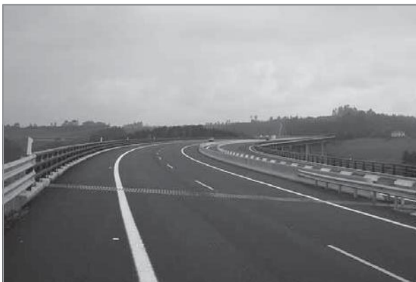
Foto 2. Los pretils son barreras de seguridad diseñados especialmente para tableros en obras de paso.
