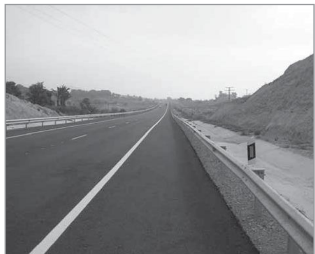
Foto 5. Los parámetros de comportamiento de los sistemas de contención son nivel de contención, severidad del impacto, deformación del sistema y capacidad de redireccionamiento.
