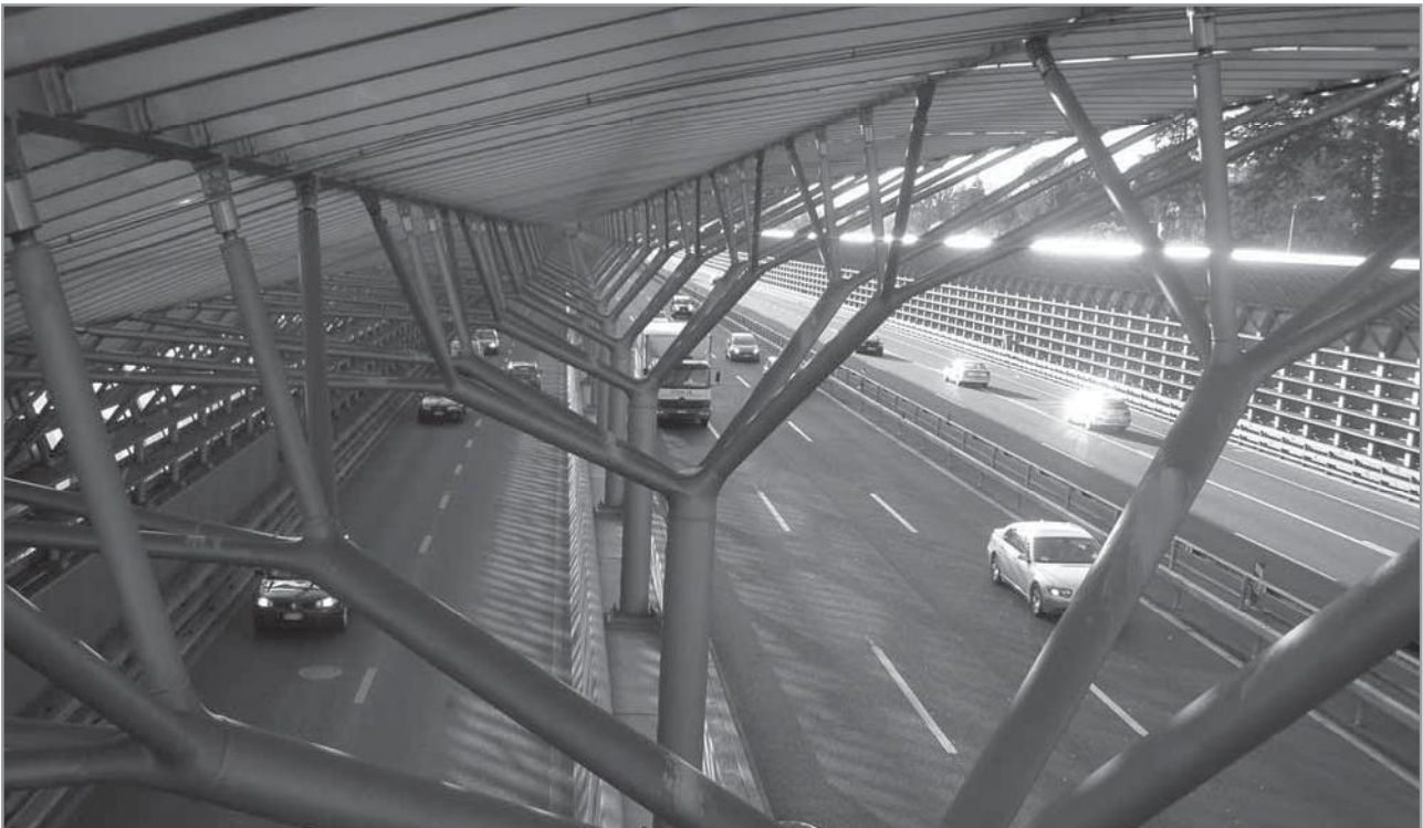
Foto 2. Las cubriciones parciales o totales son muy interesantes ya que poseen una gran capacidad de reducción del ruido viario, pero exigen una elevada inversión.
