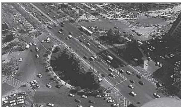
Foto 2. Infraestructuras viarias urbanas.
