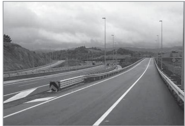
Foto 3. Atenuador de impacto, diseñado para retener un impacto frontal
