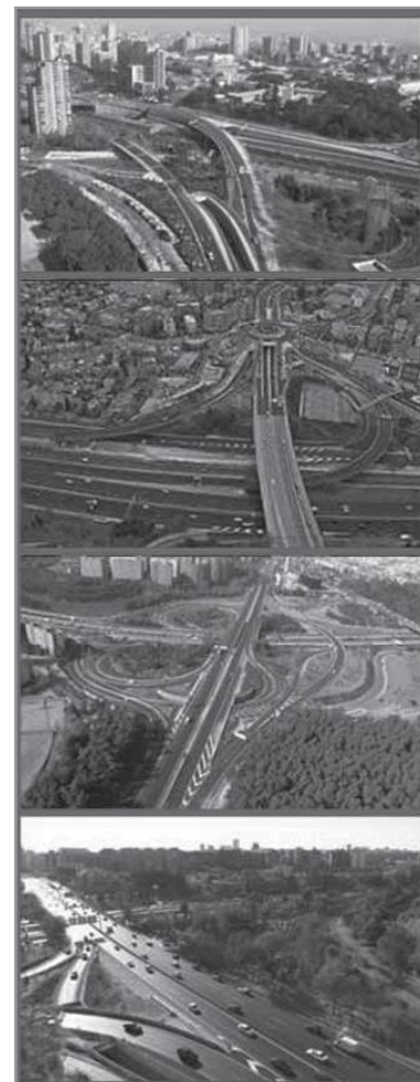
Foto 1. Infraestructuras viarias interurbanas.
