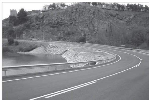
Foto 4. Las barreras metálicas de seguridad utilizan el sistema 2+ de evaluación de la conformidad.
