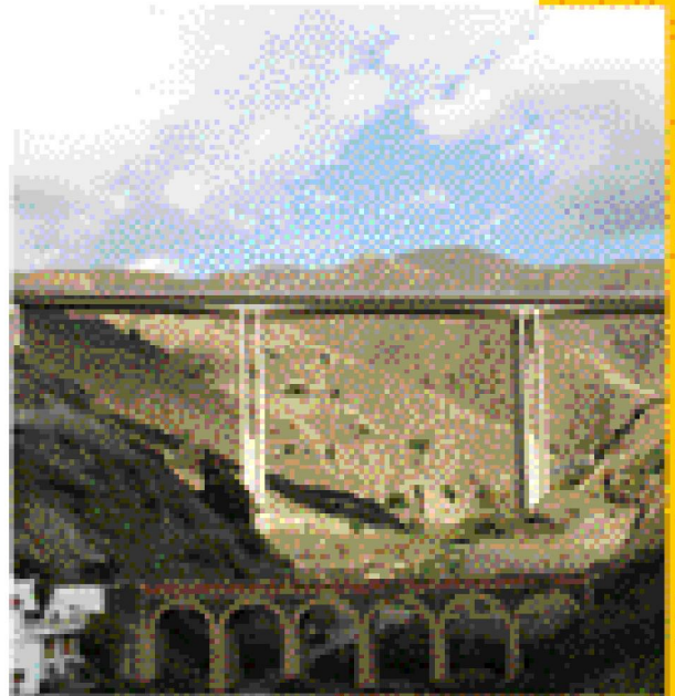
Autovía del Mediterráneo, A-7. Tramo: Albuñol-Adra.
