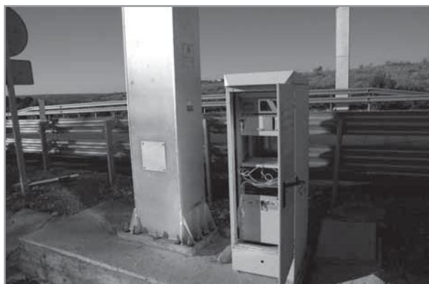
Foto 6. Instalando equipo ERU en entorno interurbano.
