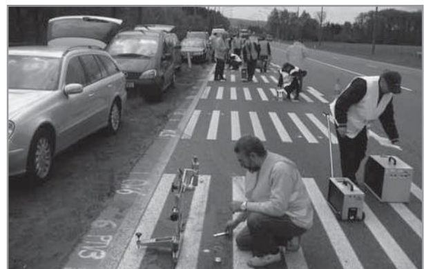
Foto 3. Vista de un ensayo de campo durante la evaluación.
