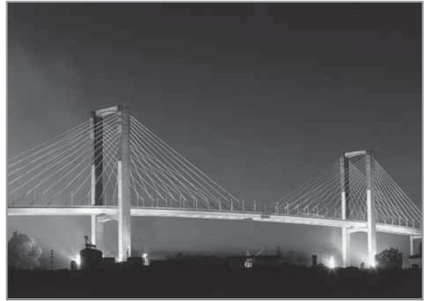
Foto 3. Puente postesado atirantado.
