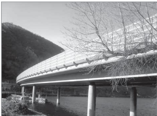
Foto 1. Pantalla reductora de ruido, colocada en un viaducto.
