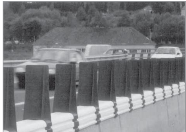
Foto 1. Pantallas antideslumbrantes colocadas en una autovía (a).
