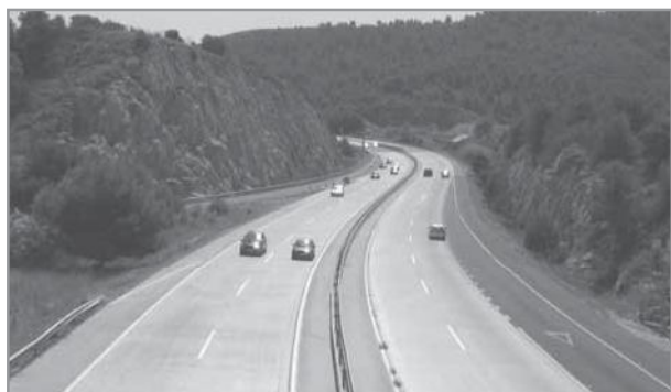
Carretera con pavimento de cemento
