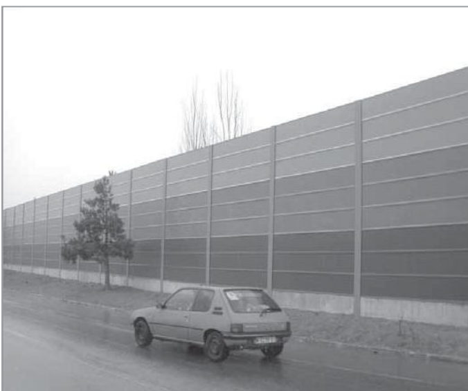
Foto 5. De acuerdo con la normativa europea, el cumplimiento de los requisitos de un dispositivo reductor de ruido se realiza mediante el ensayo de tipo inicial y mediante el control de producción en fábrica.
