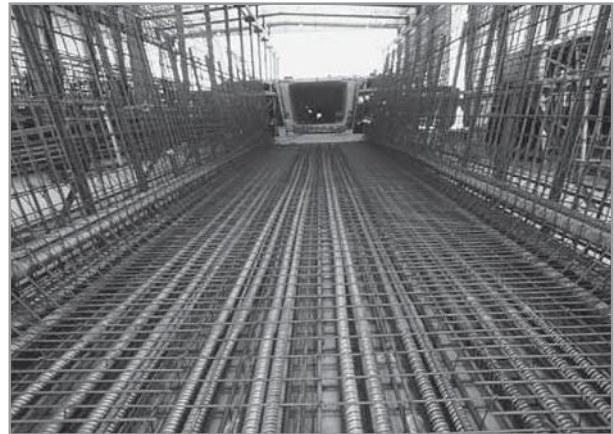
Foto 4. Viga cajón. Armadura de postesado.
